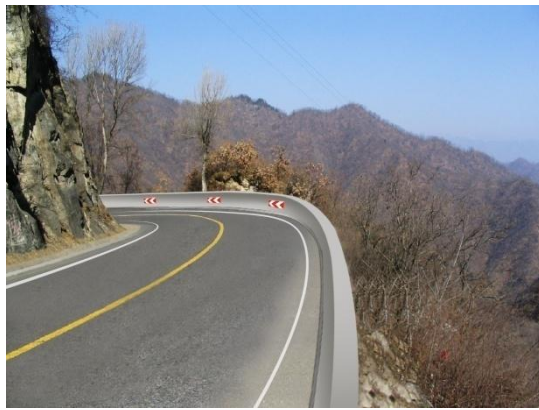
图 3-4 弯道地势险要，设置了混凝土护栏
