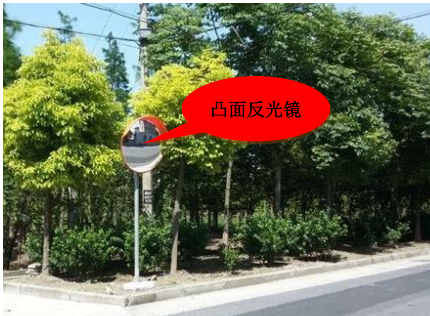
图 5.5.2 公路用凸面反光镜设置示例
