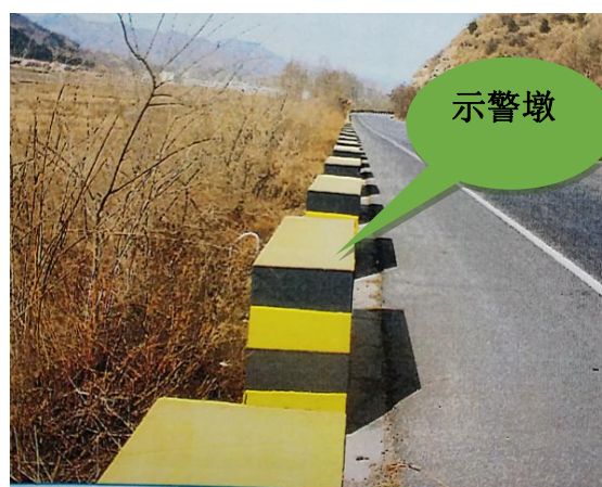
图 5. 4. 4b) 示警墩设置示例
