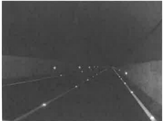
图 8-1b 隧道内突起路标和轮廓标效果示例
