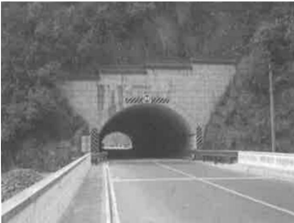
图 8-1a 护栏延伸至隧道入口内示例
