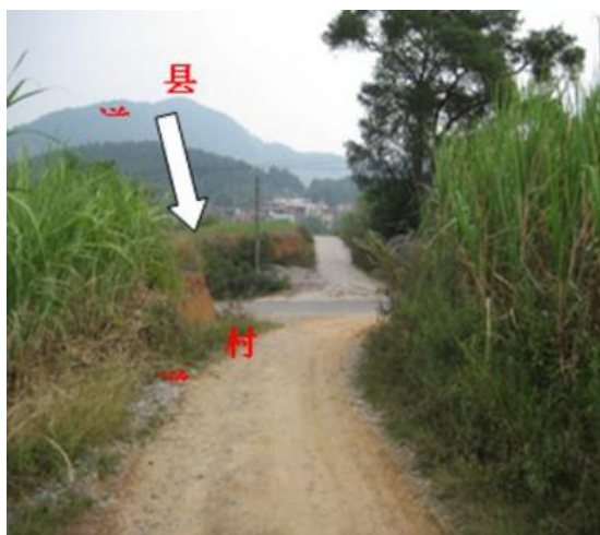
图 7-3 受土壁遮挡视距不良的平交路口
