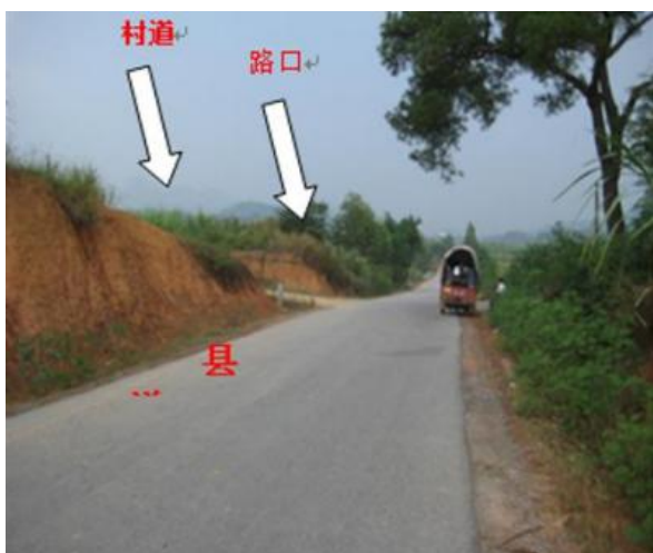
图 7-2 受土壁遮挡视距不良的平交路口
