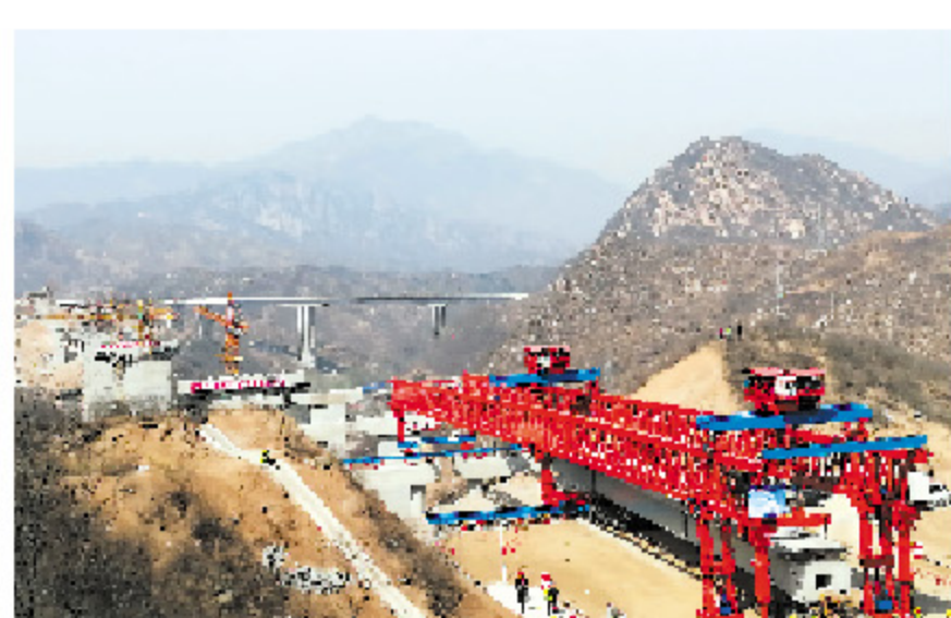
太行山高速涞曲段中交1标首片钢混叠合梁成功架设。张春辉 樊连贵 摄
