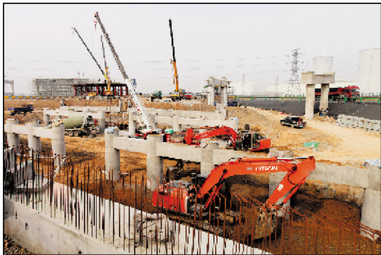
唐廊高速唐山段南湖互通施工现场一派热火朝天的繁忙景象。为确保完成通车目标,该处日前成立了南湖互通、电力拆改、路面施工、下穿铁路顶进、房建及各项附属设施5个攻坚小组,确定了责任人、完成节点工程工期,目前全线已掀起了春季施工会战高潮。 截至目前,该项目累计完成投资16.9亿元,占总投资的63.7%。 唐廊高速是京津冀交通一体化战略规划的重要组成部分,唐廊高速唐山段全长14.7公里,计划投资26.5亿元,于2017年6月开工,预计今年9月底实现全线通车。 王彬 柳崇元 摄影报道
