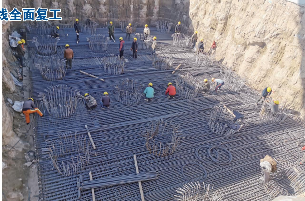
近日，新建城际铁路联络线项目一期工程实现全面复工。该项目河北段新航城站、动车所、榆安一号隧道、榆安二号隧道4个项目部开足马力，土方开挖、护坡整理、钢支撑安装作业稳步推进，为完成全年工程建设目标任务奠定了基础。
