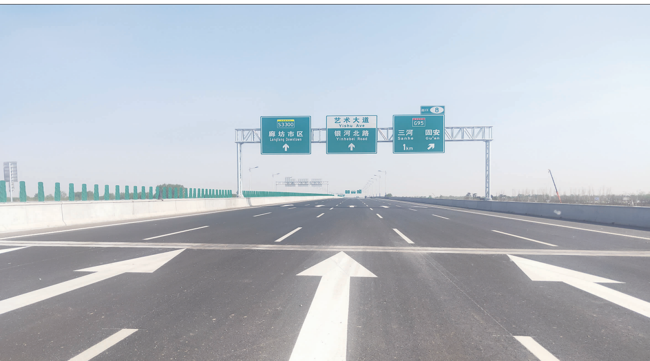
北京新机场北线廊坊段通车在即
