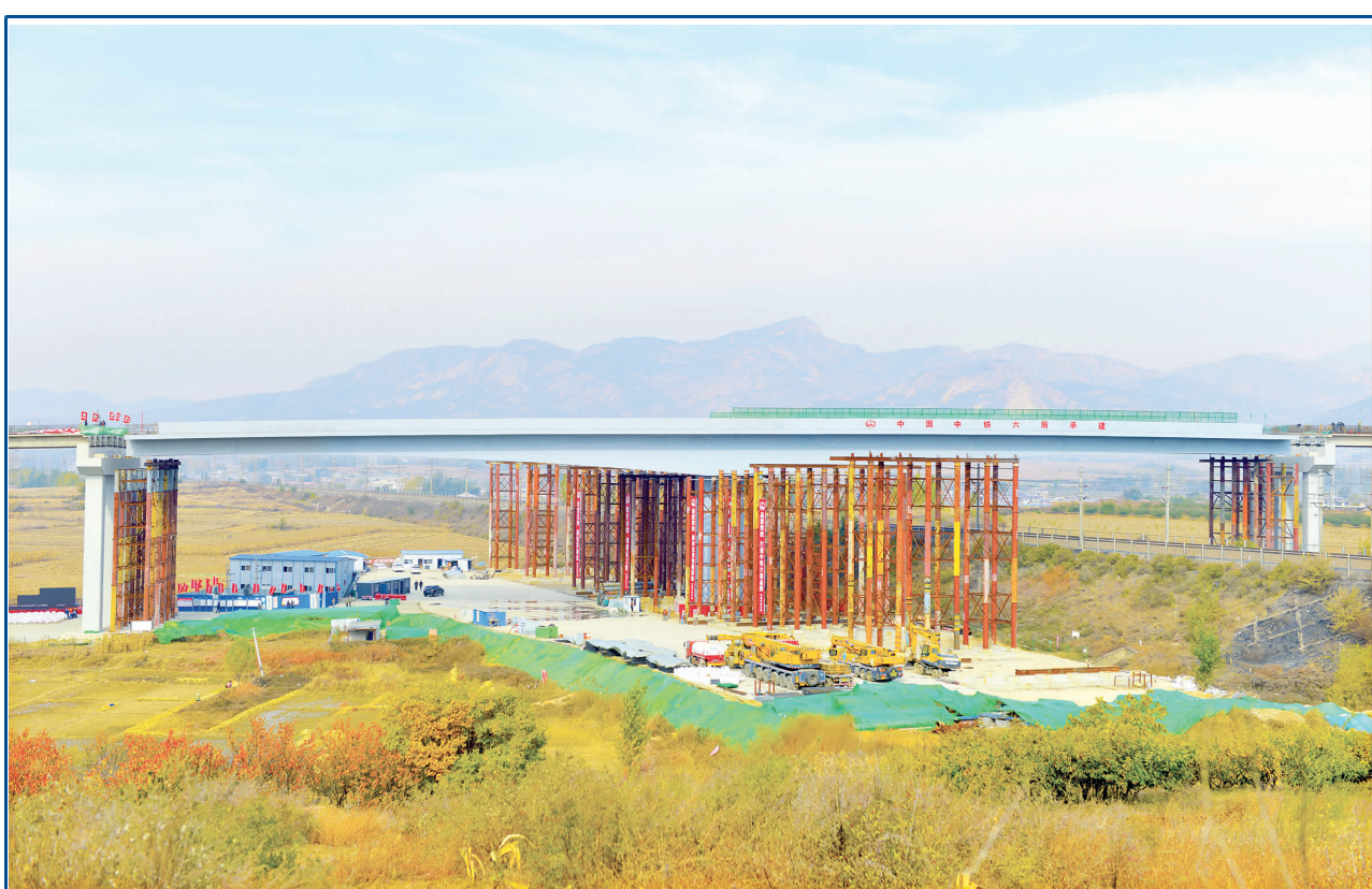
10月29日,国道102线秦皇岛市区段改造工程上跨大秦铁路转体桥,历时85分钟逆时针旋转68度与引桥实现精准对接,为项目全线贯通奠定了坚实基础。
