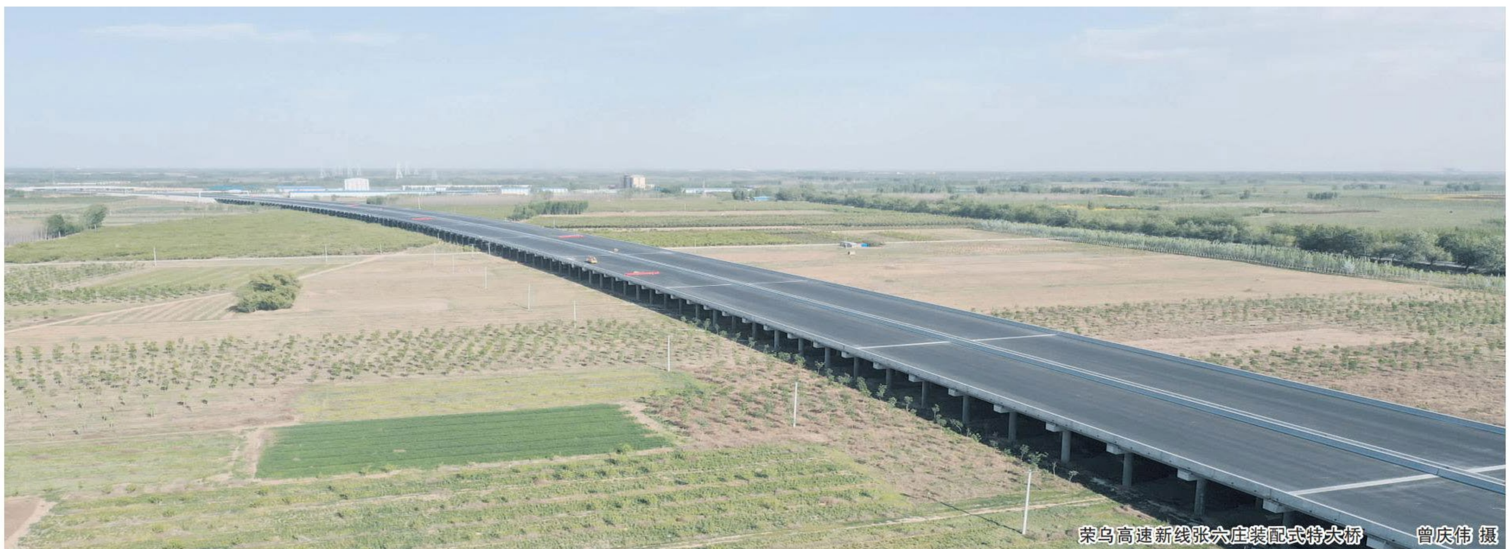
荣乌高速新线张六庄装配式特大桥 曾庆伟 摄
