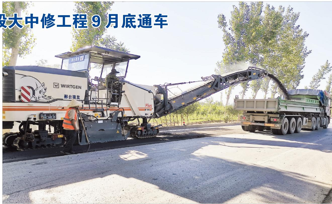
日前，国道G230巨鹿段大中修工程已全面铺开，施工人员正在铣刨沥青混凝土路面。
