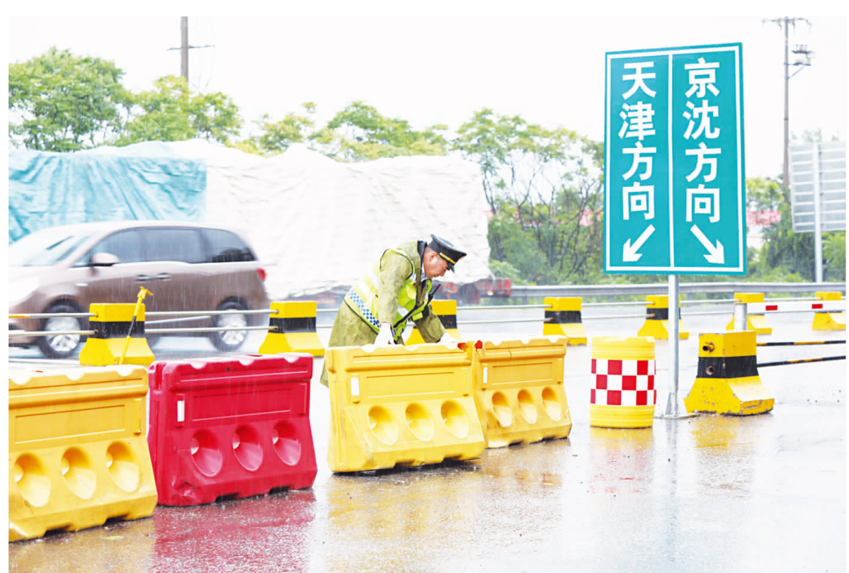
唐津高速工作人员冒雨整理隔离设施。
