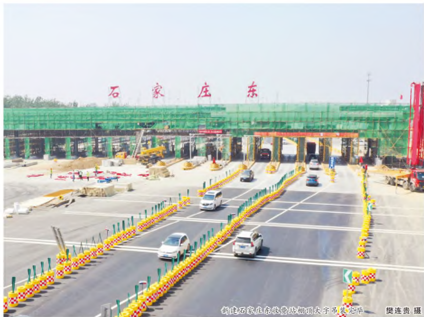
新建石家庄东收费站加顶大宇吊装完毕 樊连贵 摄
