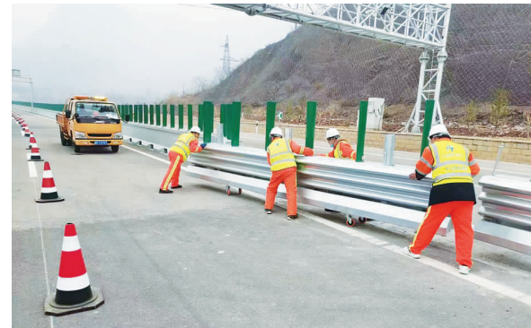
日前,中电建冀交高投公司组织开展高速公路交安设施维修保养,对路面加大巡检清扫,为司乘出行提供安全保障。图为养护工区人员对破损的防眩板进行更换。
