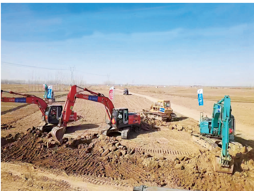
曲港高速沧州段一期工程正在紧张施工
