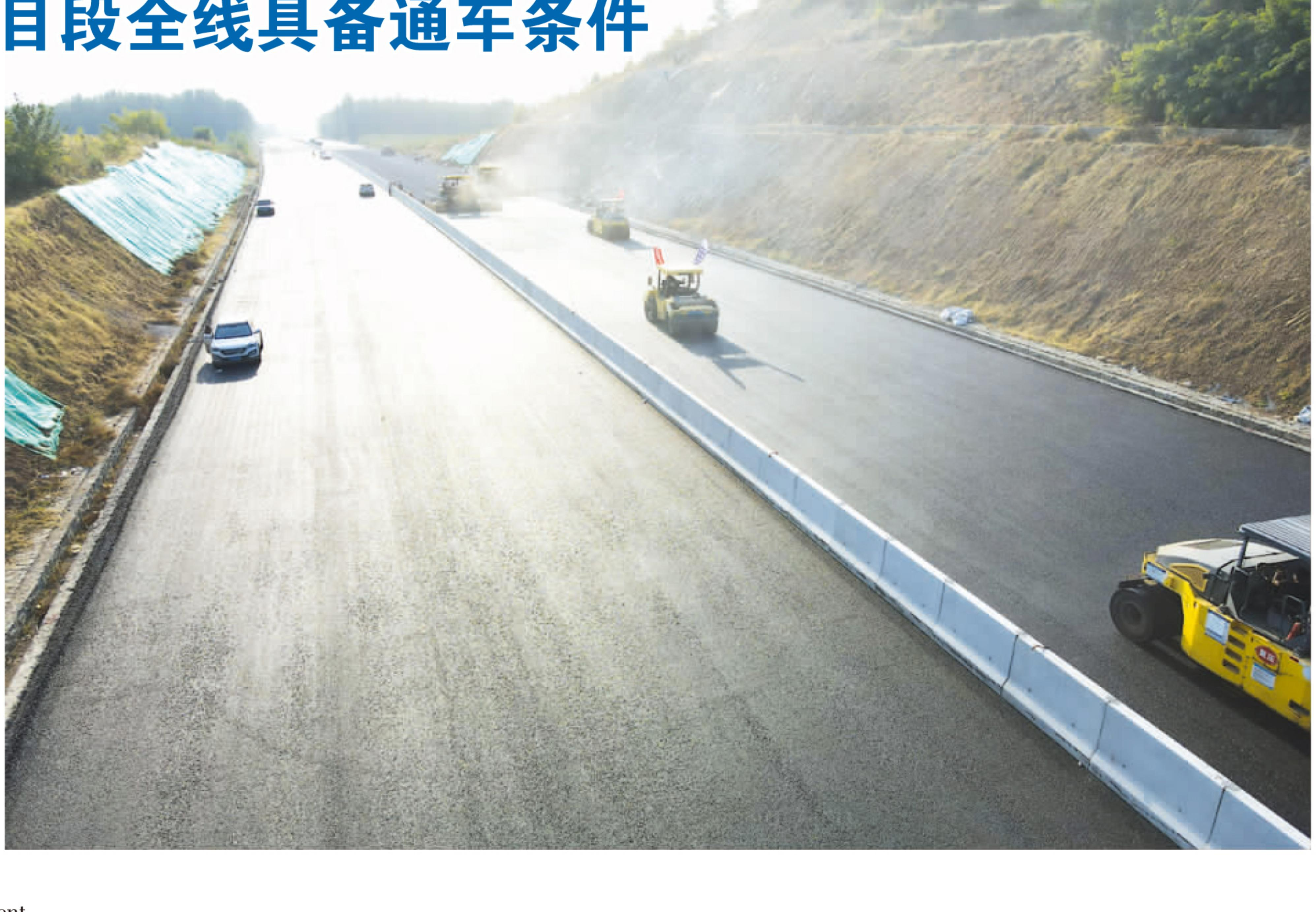
12月10日，遵秦高速B3项目段主线路面沥青摊铺圆满完成，在全线六个路面标中率先实现了主线路面工程双幅贯通，标志着该项目段全线具备通车条件，为后续交安、绿化、伸缩缝施工提供了更加畅通的运输条件。
