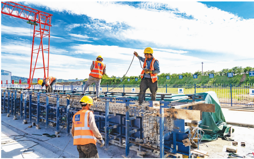
石太改扩建3分部建设者们正在紧张进行预制梁模板制作作业。
