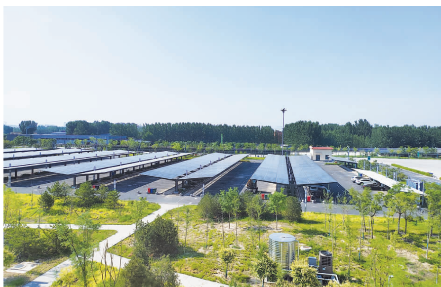
图为雄安北综合能源零碳智能服务区小轿车区光伏发电车棚。
