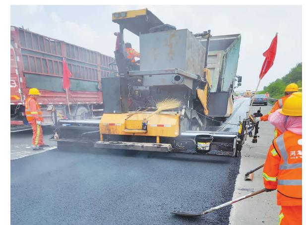
7月20日,津雄高速河北段完成2023年路面养护试验段施工,为下阶段正式全面路面养护施工奠定了良好基础。 魏立涛 石晶伟 摄影报道
