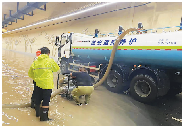
雄安交投公司工作人员在金湖隧道开口投抛、排水。
