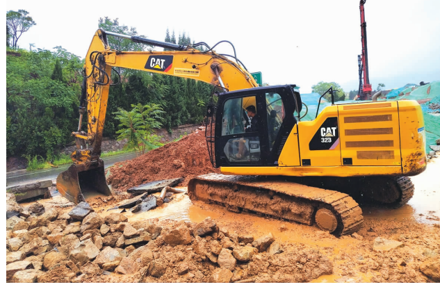
石太高速改扩建二分部组织挖掘机对涵洞及边沟进行清淤排污。
