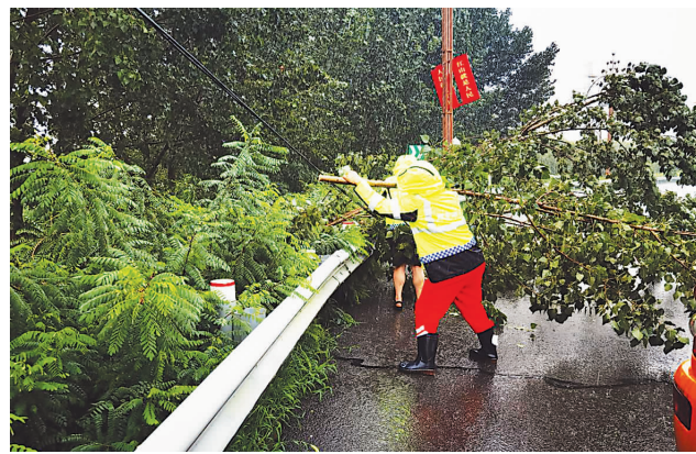
京石高速定州养护工区巡查人员清理倒伏树木。
