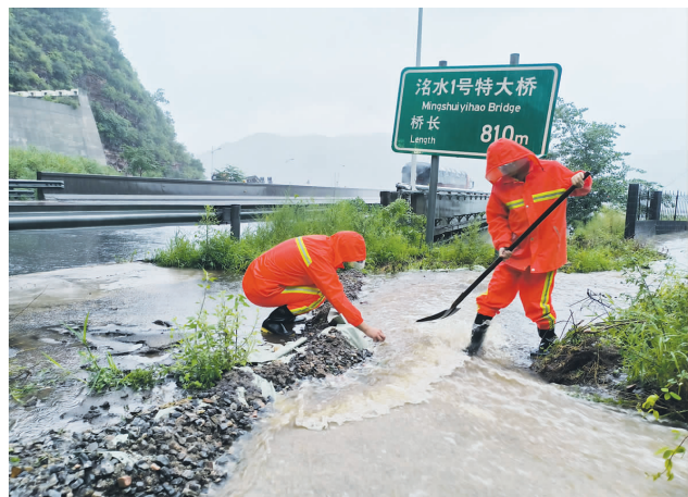
邢台高速涑水村隧道管理中心工作人员在涑水1号特大桥边维护排水设施,阻挡山坡水冲到主路。
