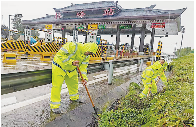
邯郸市交通建设投资管理中心防汛人员正在清理青兰高速林峰站排水渠淤堵杂物。
