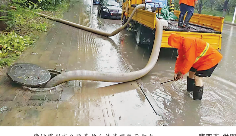
廊坊市霸州市公路养护人员清理路面积水。
