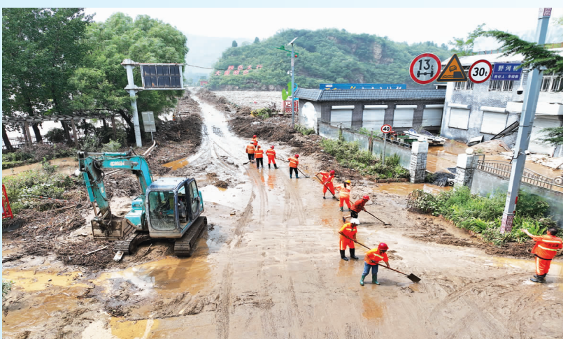
邢台市信都区公路养护人员在野河桥清淤。
