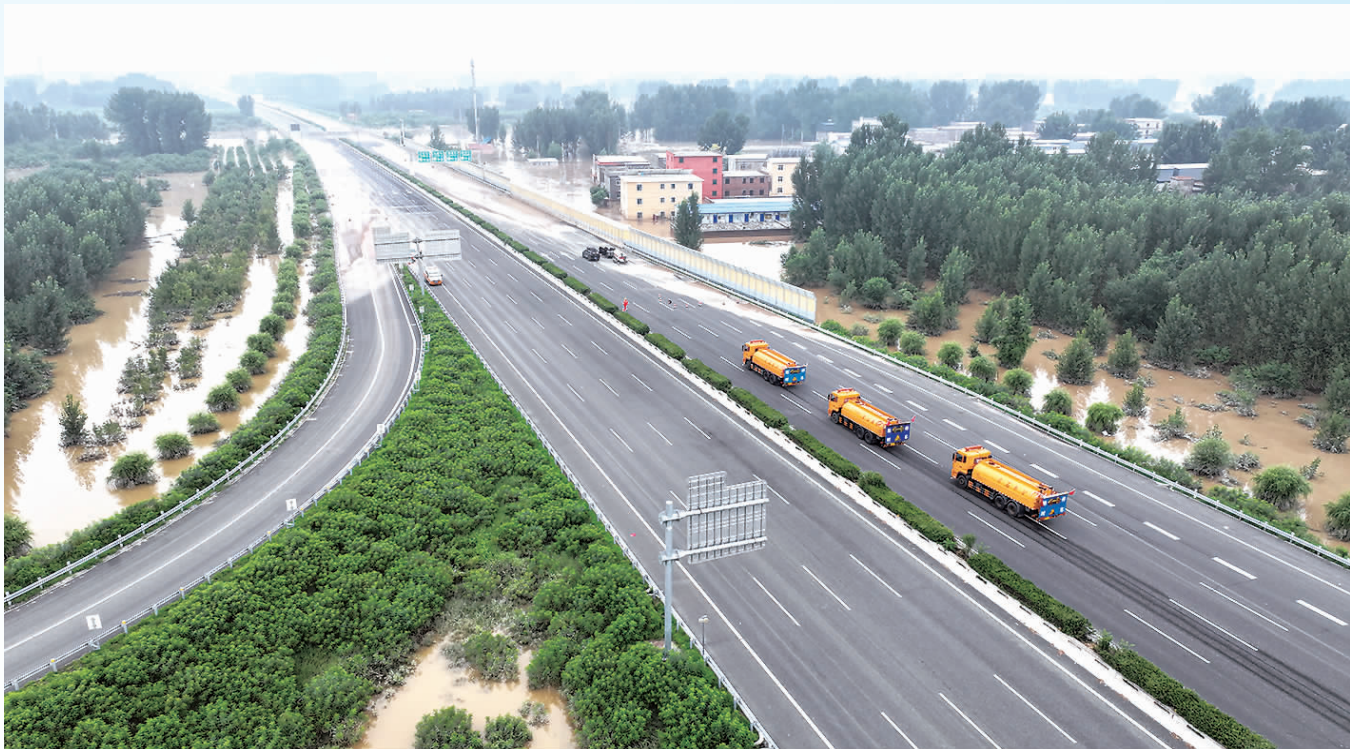
京石高速定兴养护区工人正在清理路面淤泥。
