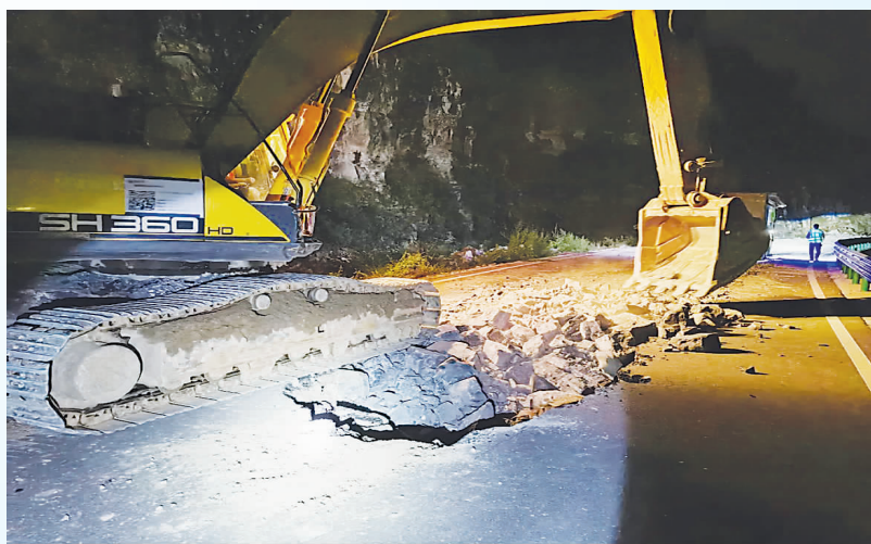
保定市易县交通运输部门连夜修复水毁路面。
