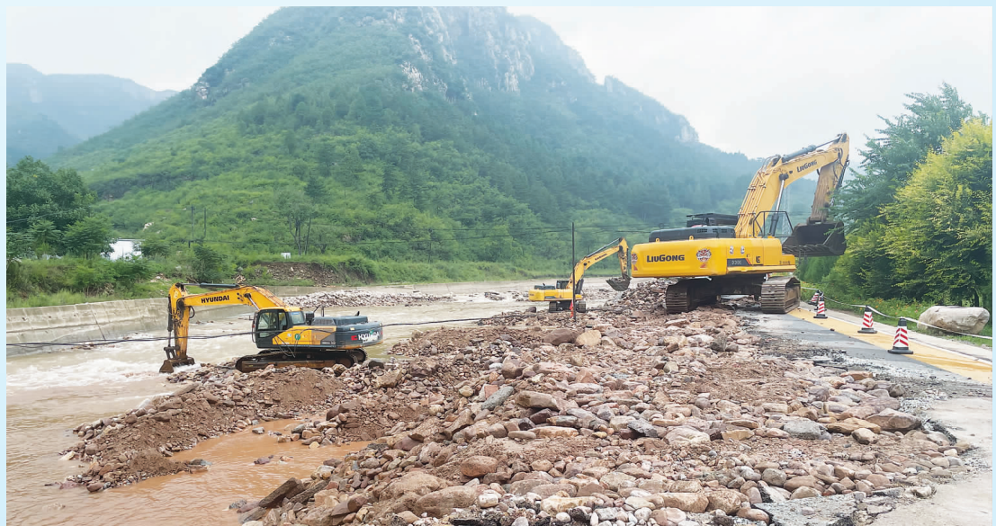
武安市交通运输工作人员正在对白云大道损毁道路进行回填加固。
