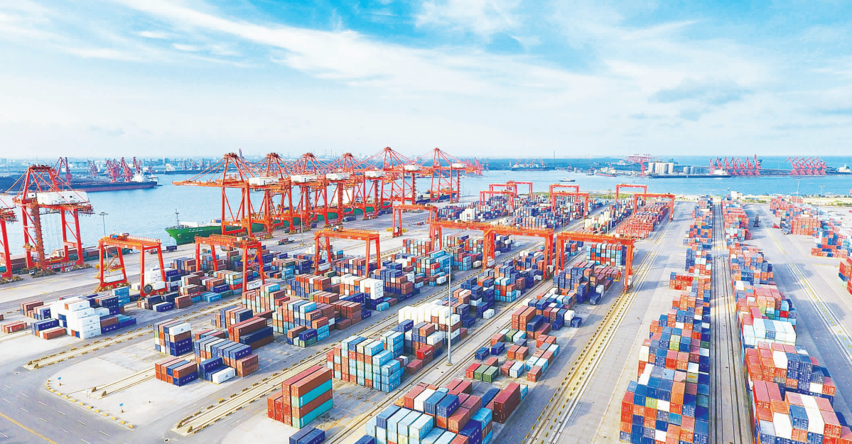
河北港口集团唐山港京唐港区集装箱作业现场繁忙有序。
