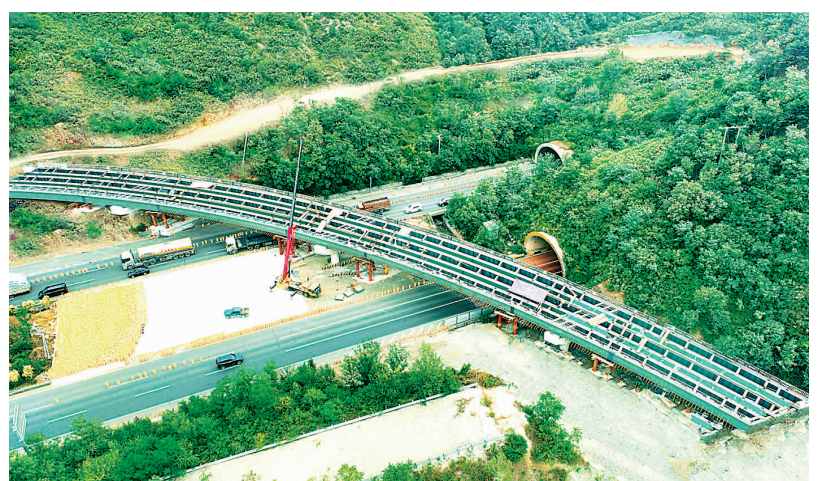
承平高速李家营枢纽互通 A 匝道钢混组合梁桥顺利架通。 张海佳 摄
