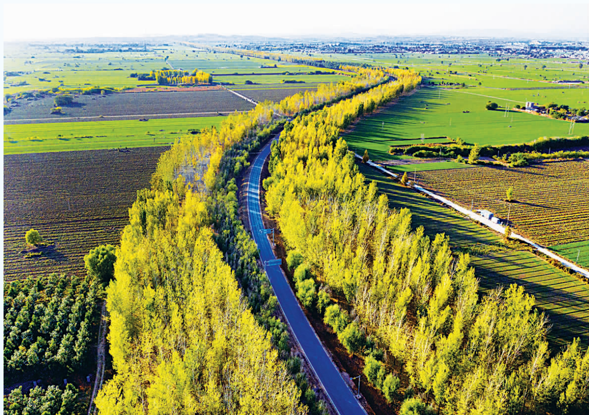
邢台三川贯通路 邢台市交通运输局 供图
