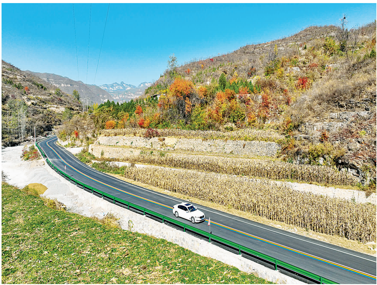
近日,井陘县水毁道路辛仙线修复工程实现竣工通车,为沿线群众提供了安全便捷的出行环境。 武家豪 摄
