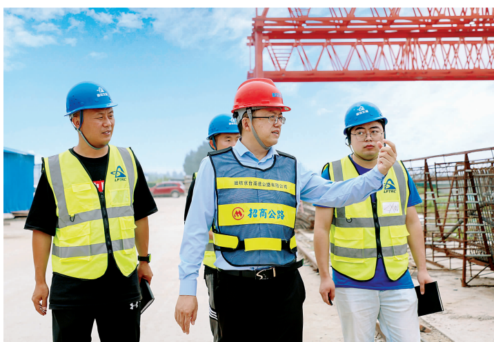
徐宗程(中)在现场检查梁板预制厂
