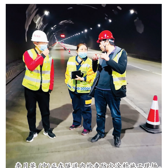
李月英(中)正在隧道内检查防火涂料施工现场。
