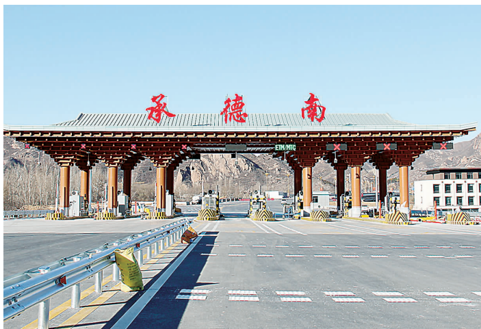
承德南互通工程建成通车
