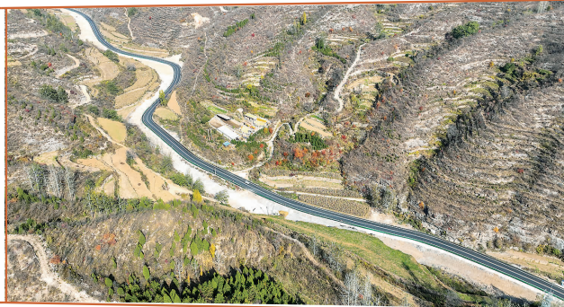
石家庄井陘县107乡道东凉线受损公路恢复完成。
