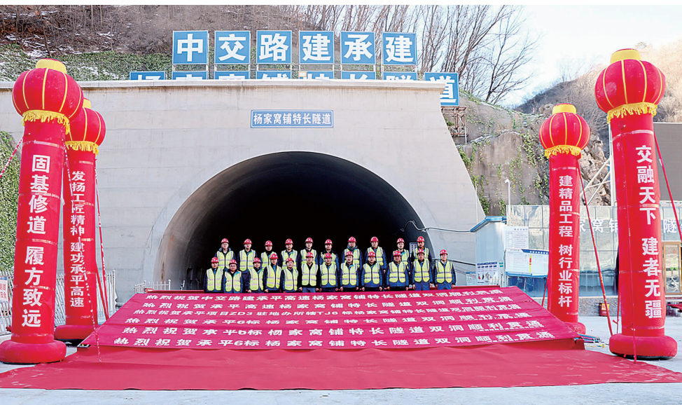
图为首环高速承平段杨家窝铺特长隧道双洞贯通。 陈飞羽 摄
