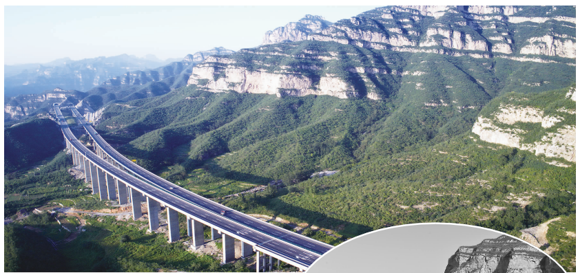
▲2023年8月30日,石家庄市京昆高速石大段栾庄大桥。
