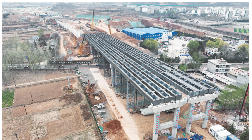
图为金良河大桥钢箱梁吊装全部完成。杨新康摄
