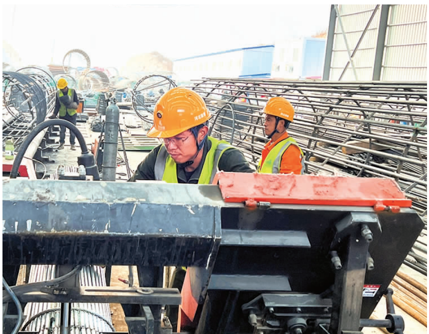
一线建设工人佩戴智能安全帽施工。
