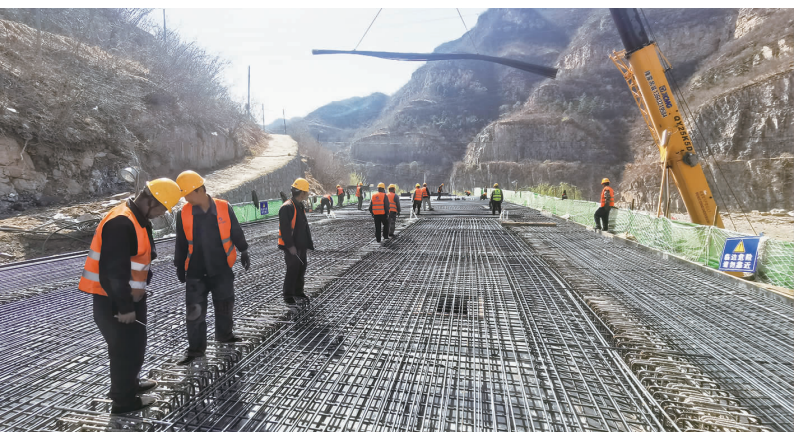
省道S334白古线井陘段大王庙桥现浇梁桥施工
