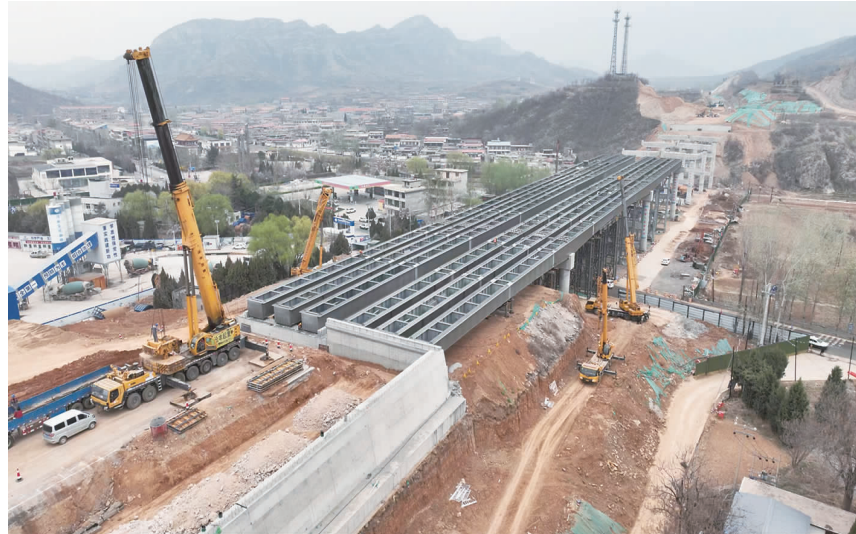
图为石太高速改扩建项目金良河大桥施工现场。
