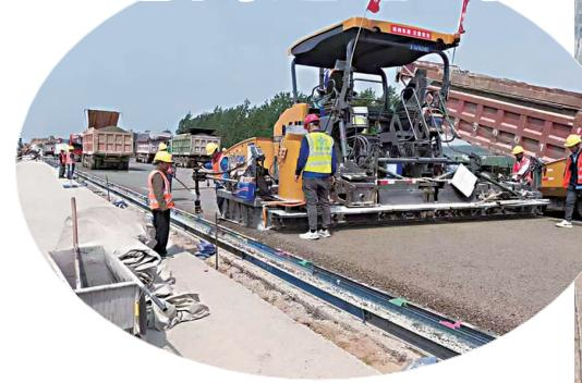
4月22日，曲港高速沧州段肃宁互通至京台高速段水泥稳定碎石双层连铺试验段顺利摊铺完成，为曲港高速大范围应用“双层连铺”新工艺打下了坚实的基础。
