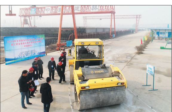
参赛选手正在进行压路机操作比武。11月26日,由中国海员建设工会组织的2018年京津冀协同发展交通一体化建设职工职业技能大赛,分别在中建二局基础设施投资有限公司平赞项目梁场及青银互通现场举行了压路机操作及公路试验检测预赛中(建设区)。 尤刚 摄影报道
