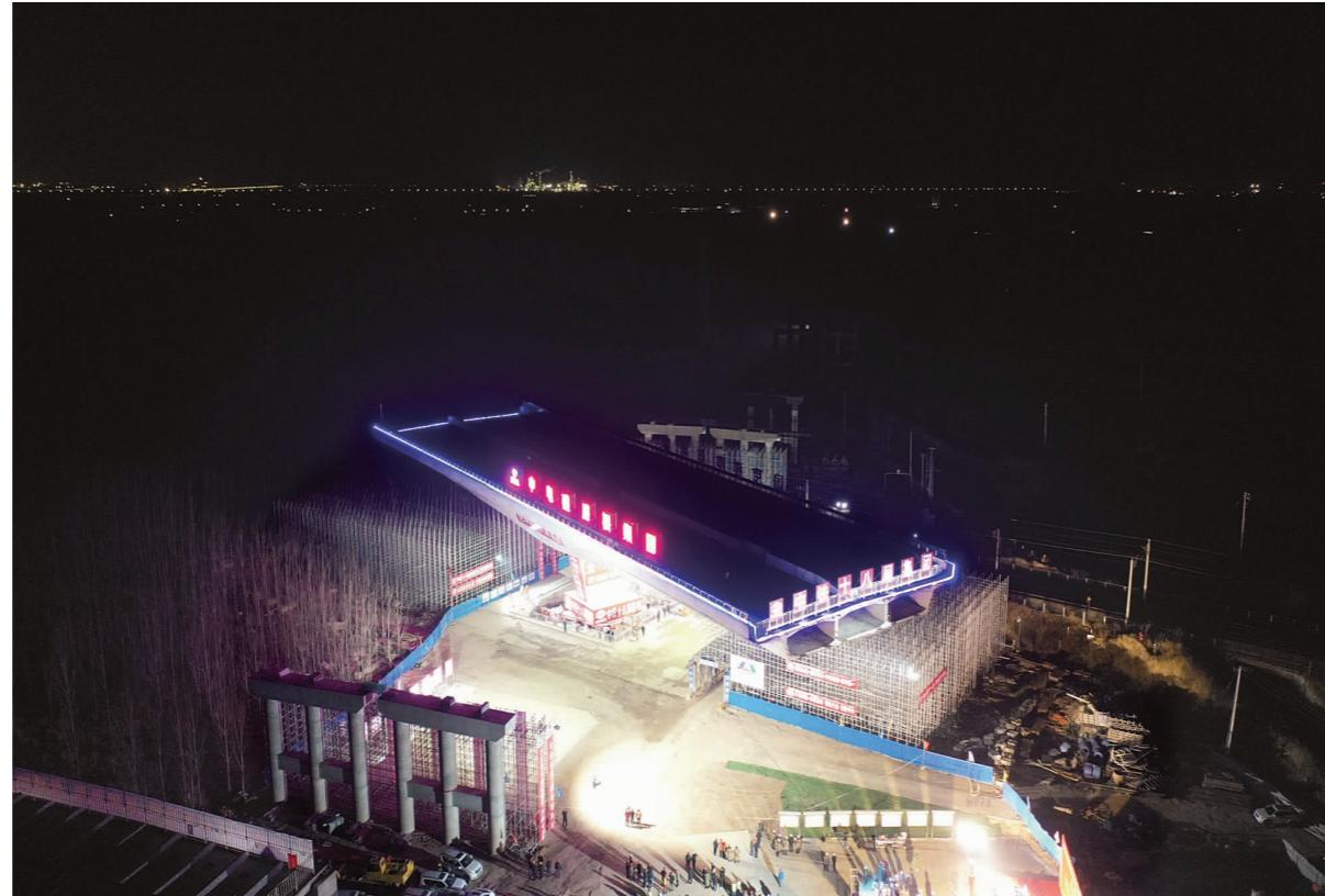
11月27日,津石高速(津冀界至保石界段)K61+658上跨京九铁路分离式立交桥主桥成功转体。
