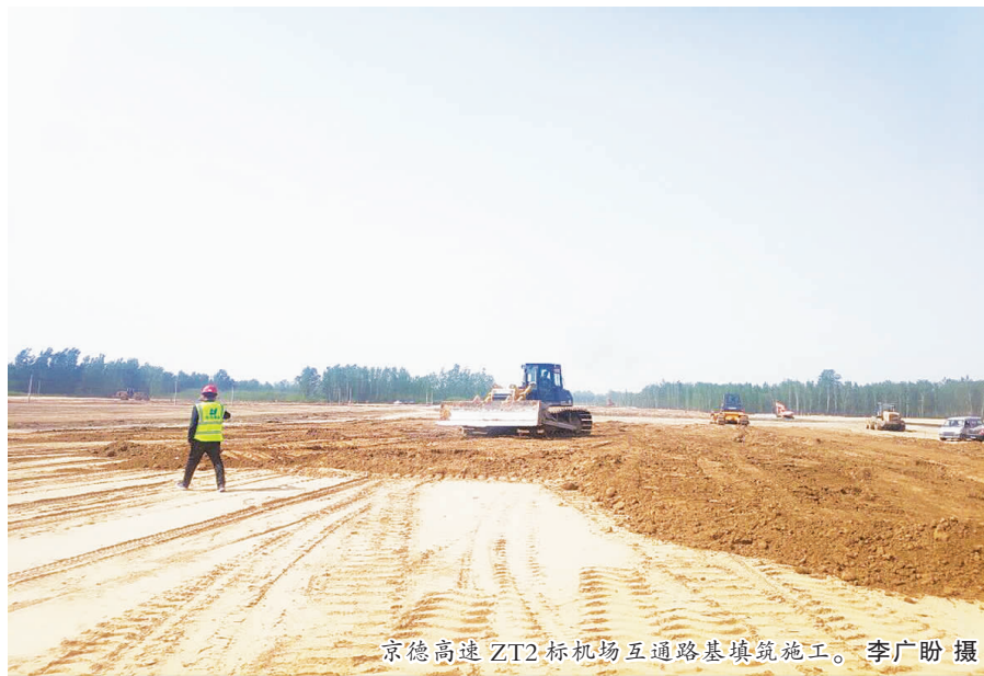
京德高速ZT2标机场互通路基填筑施工。李广盼 摄
