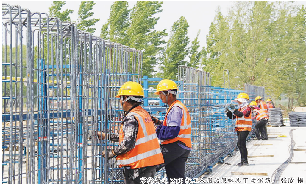
京德高速ZT6标工人用胎架绑扎T梁钢筋。张欣 摄
