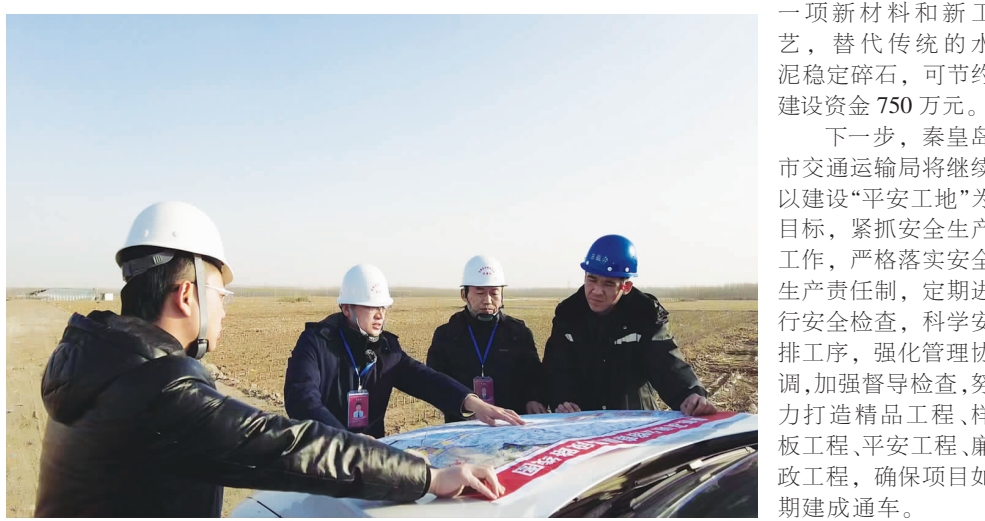
秦唐高速秦皇岛段施工现场，项目工作人员正在查看施工图纸。
