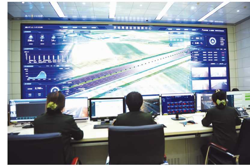
京哈高速公路智能化建设项目路况信息中心。
