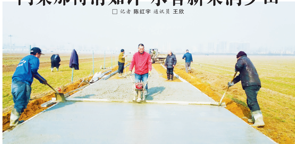
为保证村民春耕,正定县交通运输局对田间机耕路进行硬化作业。
