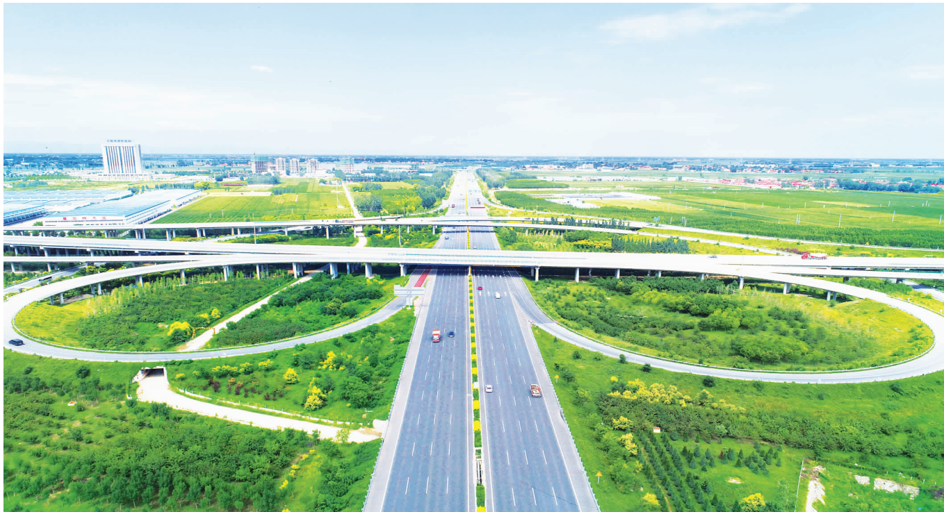
图为京石高速与荣乌高速互通枢纽。
