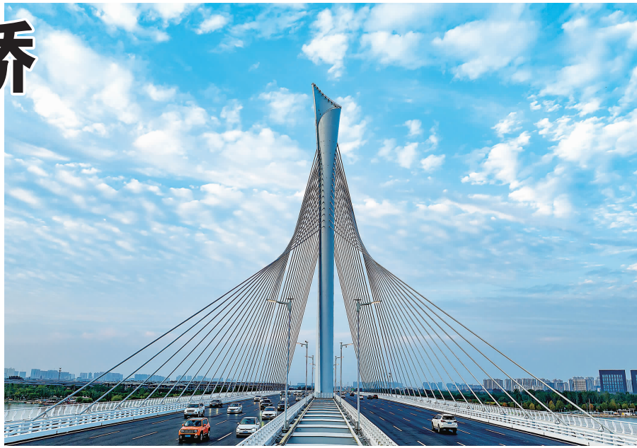
滹沱河特大桥。
