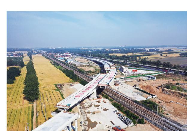
5月28日,国道G307石家庄市晋州绕城段改建工程跨石德铁路2号分离式立交转体桥成功转体,左右幅同步转体总重量12000吨,最大跨度140米,为我省小曲线半径、最大跨度公路转体桥。该桥的成功转体,为国道G307晋州绕城段改建工程10月建成通车奠定了坚实基础。
