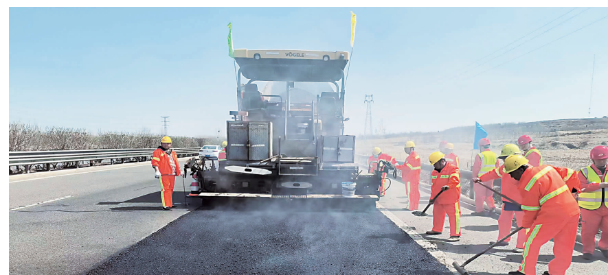
施工人员在摊铺沥青路面。
